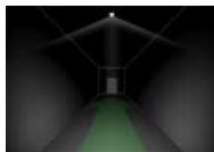
Éclairage d'évacuation avec optique asymétrique
